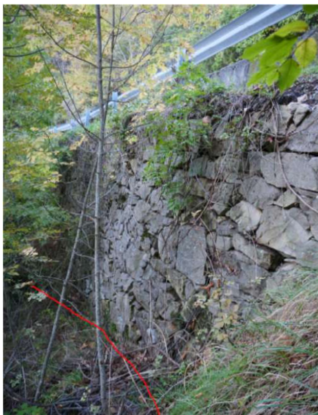
Figura 3 (tratta da relazione geologica) - Vista del muro in pietra di sostegno della scarpata
