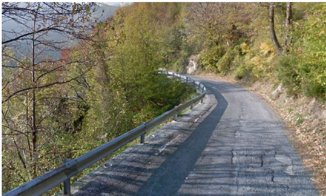
Figura 4 (tratta da Google Earth) - Segni visibili del dissesto del manto stradale
